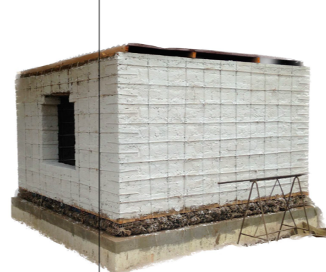
Aislamiento sísmico de vivienda rural con shicras
