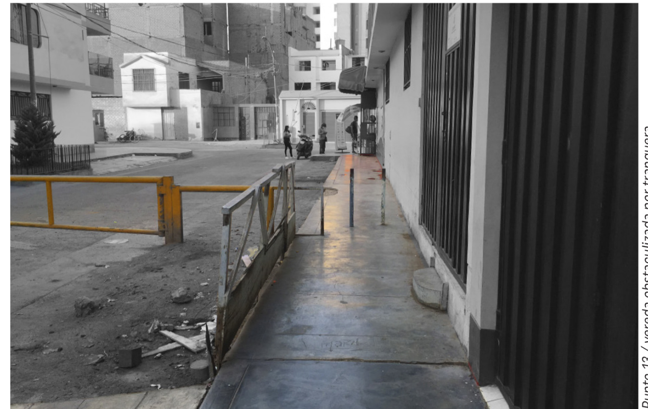
Punto 13 / vereda obstaculizada por tranquera
