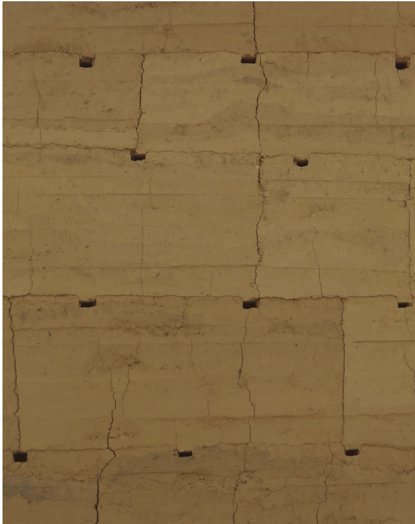
1 Detalle de muro de tapial en Wayku, Lamas. Fotografía: Teresa Montoya, 2015.
